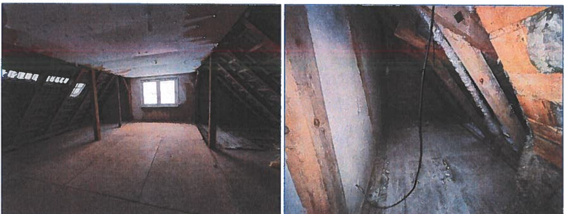
Abb. 6 und 7 Ansichten vom Obergeschoss
