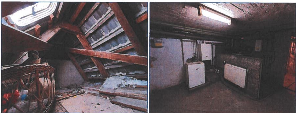
Abb. 4 und 5 Ansichten vom Dachboden und Keller
